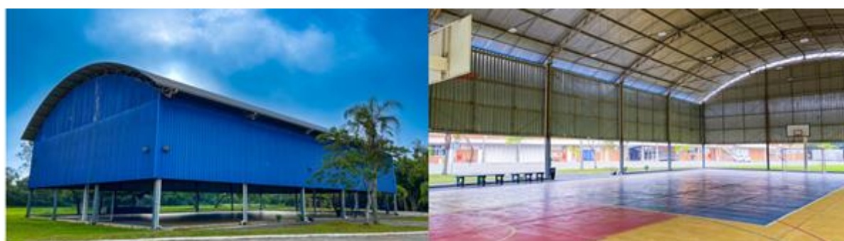
Figura 32 - Registro Fotográfico da Quadra poliesportiva coberta do campus Balneário Camboriú
